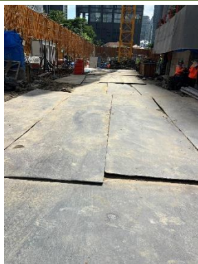
รูปที่ 16 แผ่นเหล็กอย่างหนาปูพื้นที่เดินรถในโครงการ
