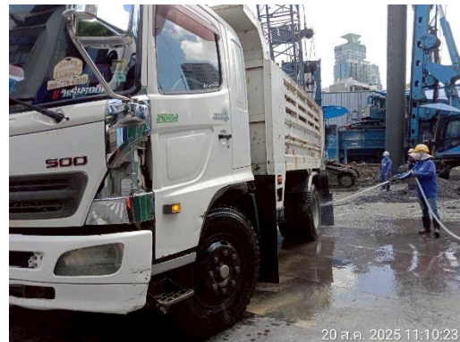
รูปที่ 15 เจ้าหน้าที่ล้างล้อรถบรรทุกด้วยสายยางฉีดน้ำแรงดันสูง (Water Jet)
